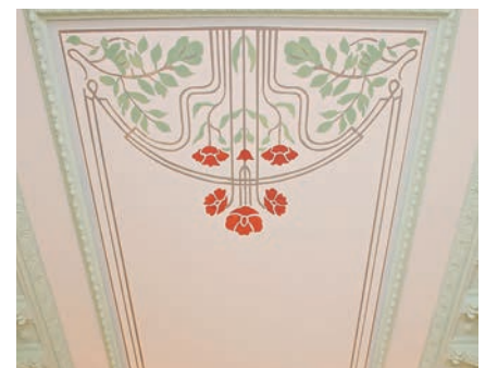
Hochwertige Stuckarbeiten in einem Objekt in der Delitzscher Straße
